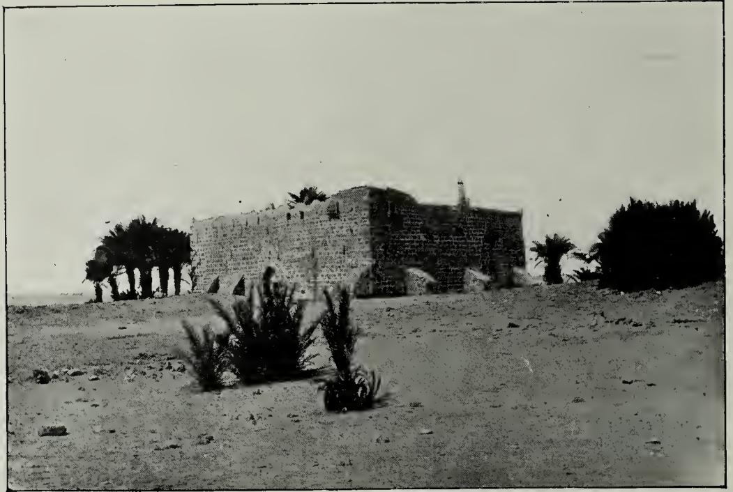
Fig. 39. — DĀT EL-ḤAĞĞ. Le château vu du sud-ouest.
